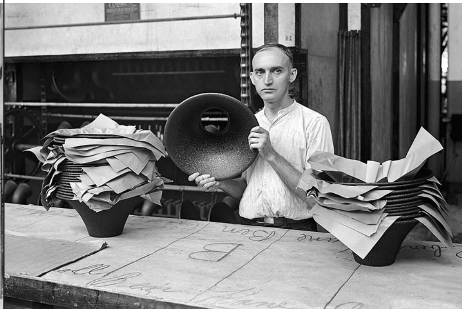
Hangszóróalkatrész végső vizsgálata a philadelphiai Atwater Kent rádiógyárban, 1925
